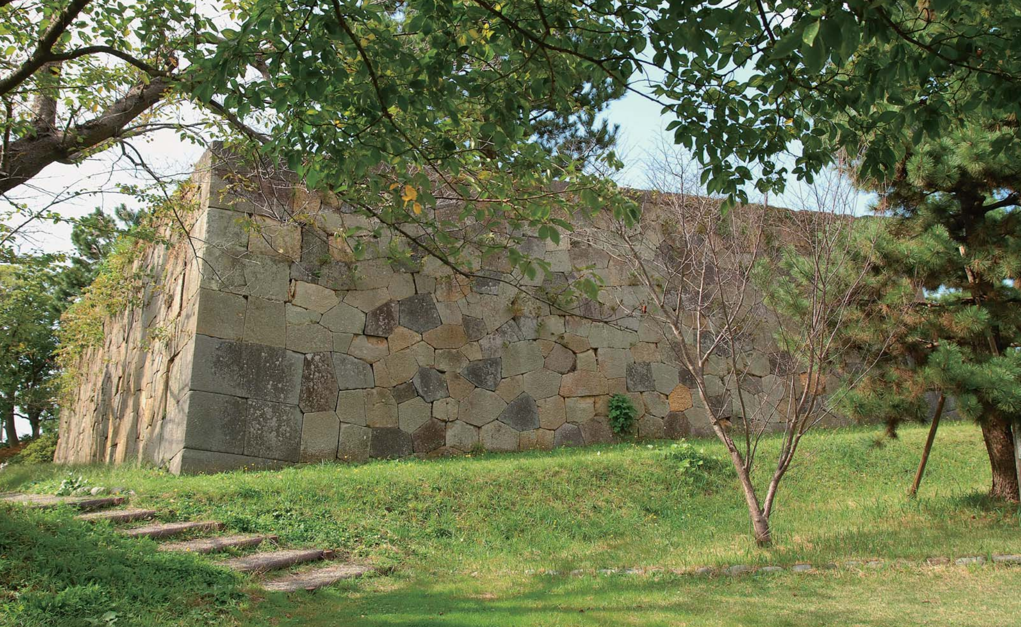
小松城本丸天守台石垣(小松高校グラウンド西側)。切込みハギという当時の最新の石垣工法が用いられた。金沢の戸室石、小松の鵜川石という種類の異なる石が美しいパッチワーク風の意匠を作り出している。この上に風流な二重三階の数寄屋造りの櫓(やぐら)があった。
